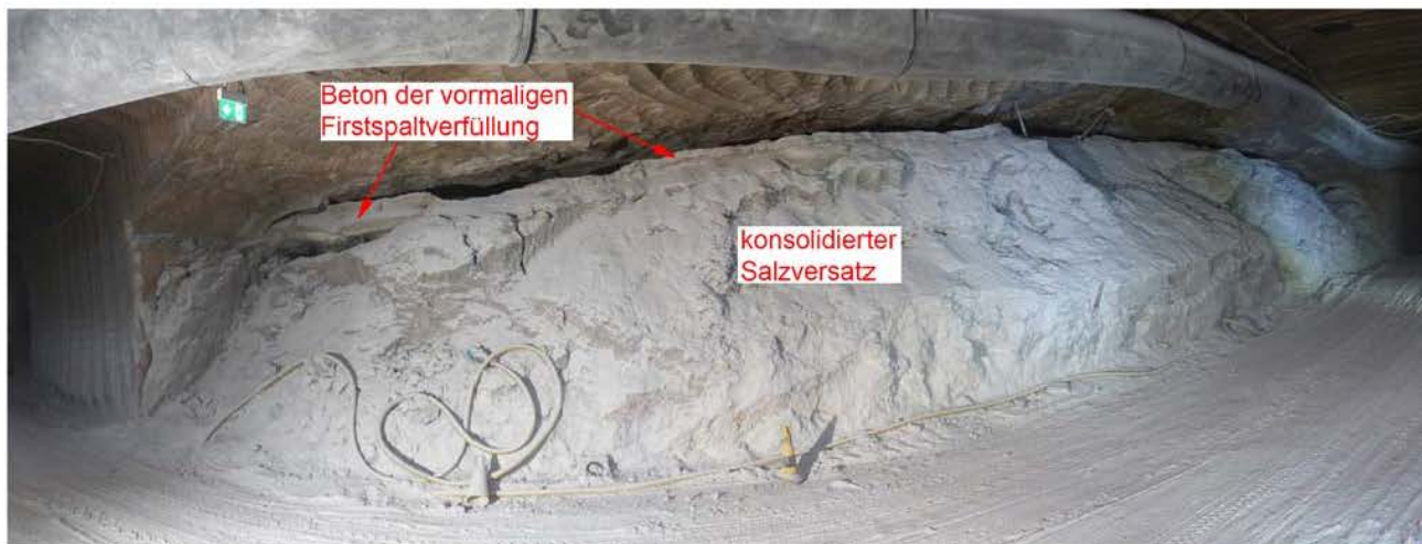
Abbildung 4.28: Nebenabbau 8a/532, Böschung der Verfüllung mit Firstspalt, Blick nach Südwesten, Stand: 25.01.2018
