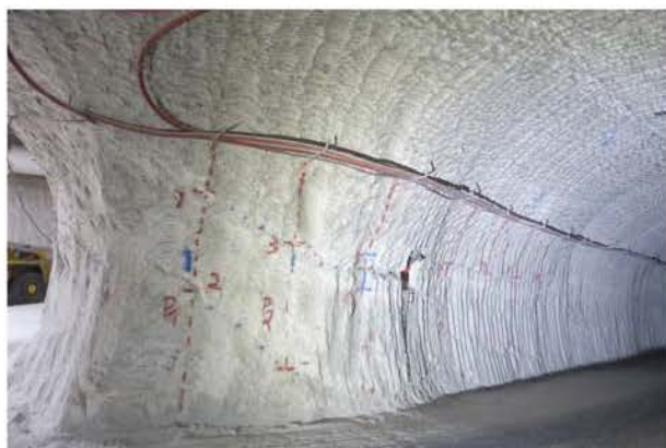
(a) Südstoß im Ostteil der Wendelstreckenumfahrung zur 775-m-Sohle mit steil einfallenden Trennflächen und Fissurometer 037F
