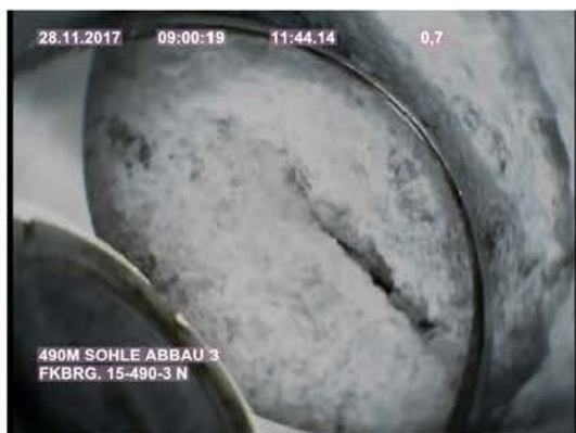
Abbildung 4.2: FK-Brg. 15/490-3, Tiefe: 0,7 m, Ansicht: Nord
