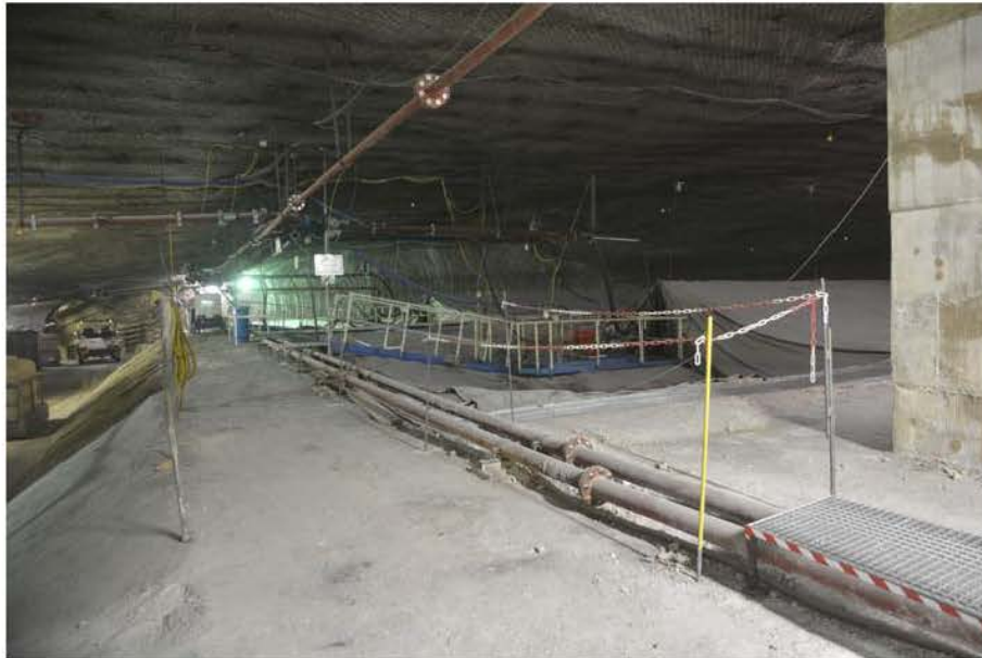
Abbildung 4.1: Fotoaufnahme des Abbaus 3/490 vom 09.03.2018. Blickrichtung: Südost
