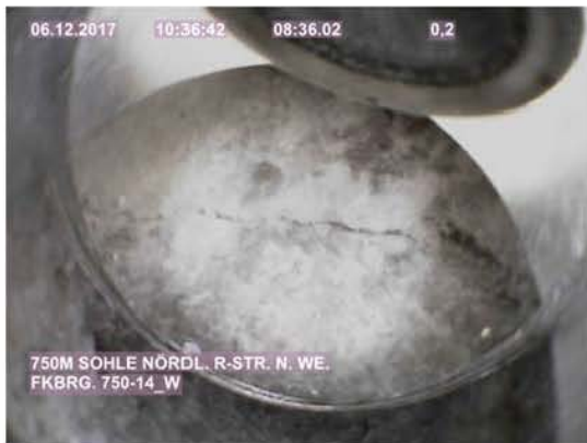
Bild 36: Beginnende konturnahe Rissbildung (FKBrg.750-14, Teufe: 0,20 m)
