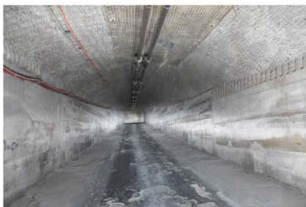
(a) Westlicher Wendelstreckenabschnitt von der 725-m- zur 750-m-Sohle mit Stabilisierungsmauern an Nord- und Südstoß
