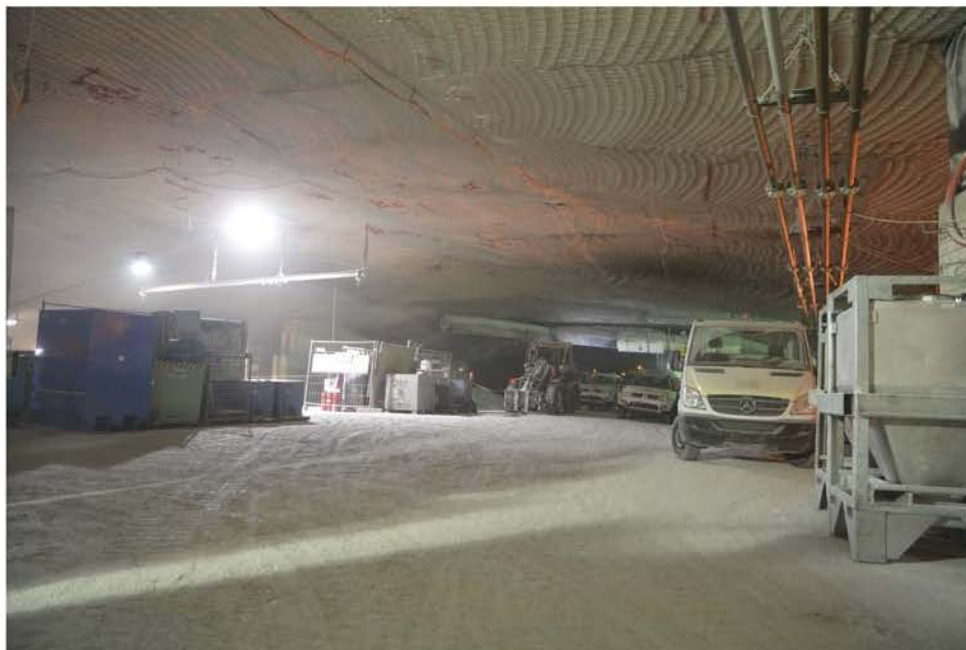
Abbildung 4.9: Fotoaufnahme des Abbaus 4/490 vom 09.03.2018. Blickrichtung: Süd-West
