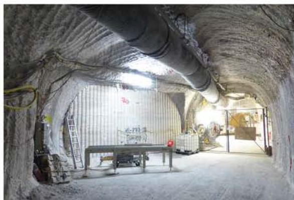
(b) Verfüllter Querschlag zum Gesenk östl. Kaliabbau 12-Ost und Bohrort vor verfülltem Dammjoch, Blick nach Osten
