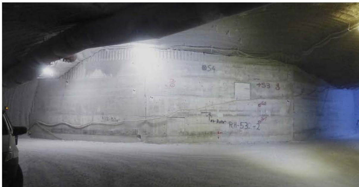
Abbildung 4.27: Nebenabbau 7b/532 Blick auf die Sorelbetonmauer, die den südlichen Teil abtrennt, Stand: 21.02.2018
