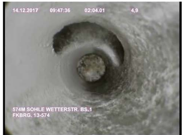
Bild 9: FKBrg. 13/574 – Querung von FKBrg. 12/574 bei ca. 4,9 m
