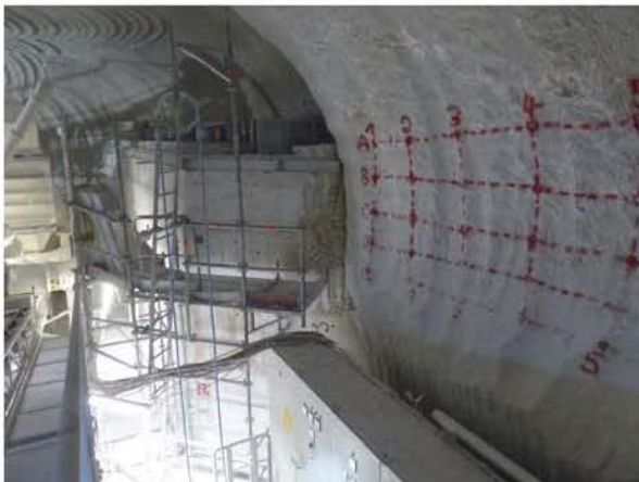
(a) Erstellung des Stützbauwerks am südöstlichen Stoß der 20BA, bei Aufnahme ca. 4,7 m hoch, Blick nach Südosten
