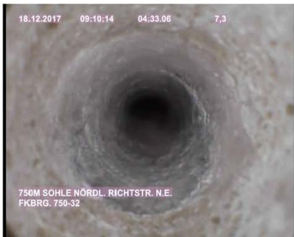
Bild 48: FKBrG. 750-32 – Position bei 7,2 m kraftschlüssiger Übergang Sorelbeton– Steinsalz
