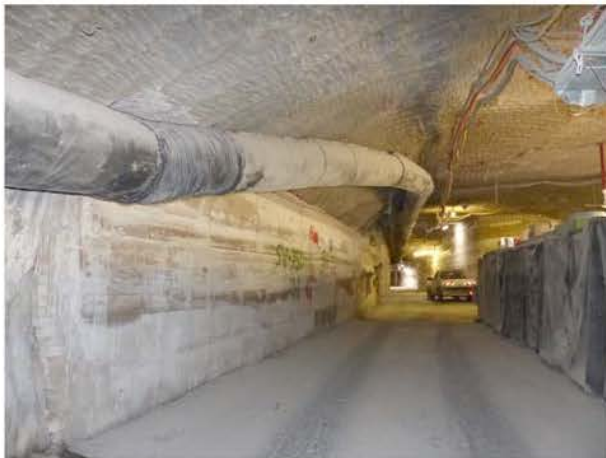
(a) Stabilisierter Südstoß mit Sorelbeton-Stützbauwerk vor Zugang Abbau 5a(Na2) und Pausenplatz, Blick nach Westen, 22.01.2018
