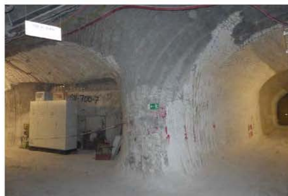
(b) Vollständig mit Sorelbeton verfüllte Schrägstrecke nördlich Vahlberger Strecke, Blick nach Osten, 15.02.2018
