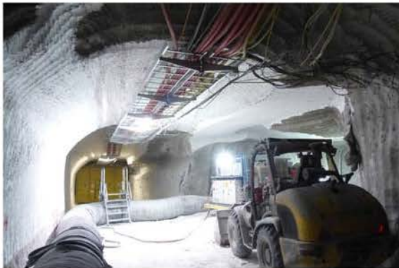
(a) Nachschnittarbeiten am Südstoß der Vahlberger Strecke und in dem alten Traforaum, Blick nach Osten
