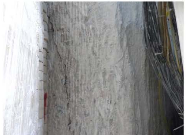
(b) Ab einer Höhe von ca. 2 m über der Sohle schließt das Stützbauwerk die Risse des Beobachtungsbereichs 5 ein, Blick nach Nordwesten
