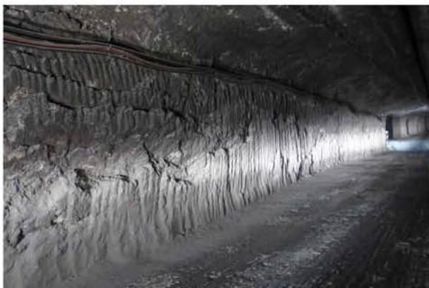
(a) Südstoß mit intensiven Abschaltungen im Bereich zwischen Zufahrt Abbaubegleitstrecke 553-m-Sohle und Zufahrt Wetterstrecke Bl. Sch. 1, 574-m-Sohle.
