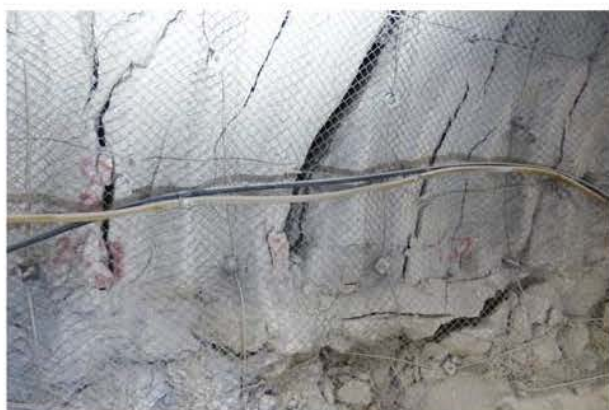
(a) Intensiv durch Vertikalrisse entfestigter Südstoß von Pfeiler 3/4, Blick nach Süden, 16.02.2018
