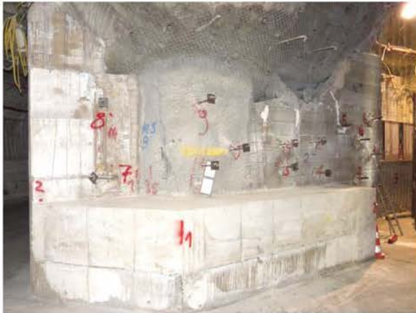
(a) Die Risse aufweisende Spritzbetonstabilisierung der Pfeilerecke (u.a. MS9) sowie die sich ablösende und fragmentierte Sorelbetonmauer werden sukzessive durch Mörtelinjektionsanker und eine Stützmauer stabilisiert, Blick nach Westen (27.10.2017)
