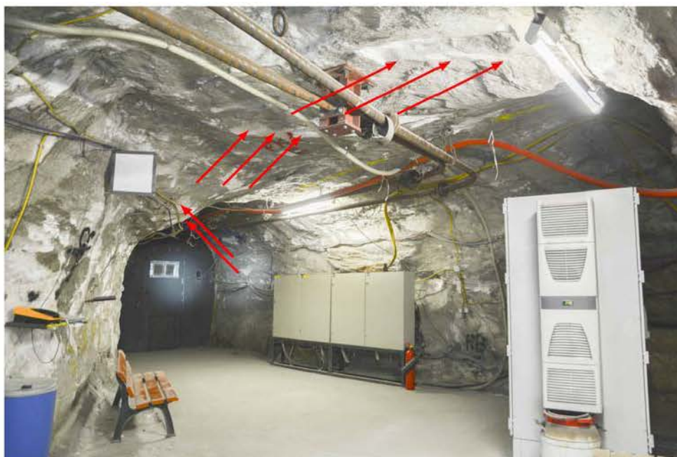
Abbildung 4.19: Fotoaufnahme des Füllortes Schacht 4/490 vom 04.04.2018. Blickrichtung: Süd-West
