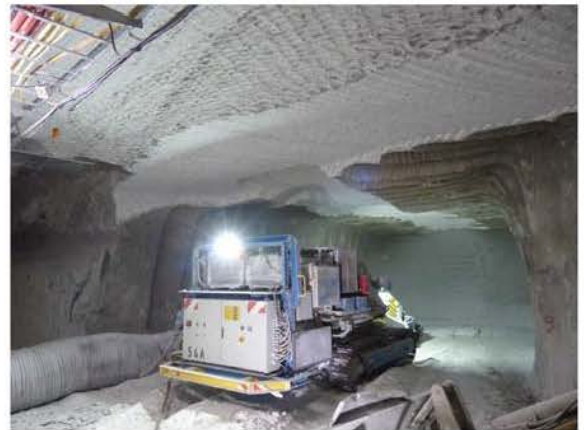
(b) Vorbereitung des geräumten ehemaligen Traforaums zur Verfüllung, Blick nach Süden
