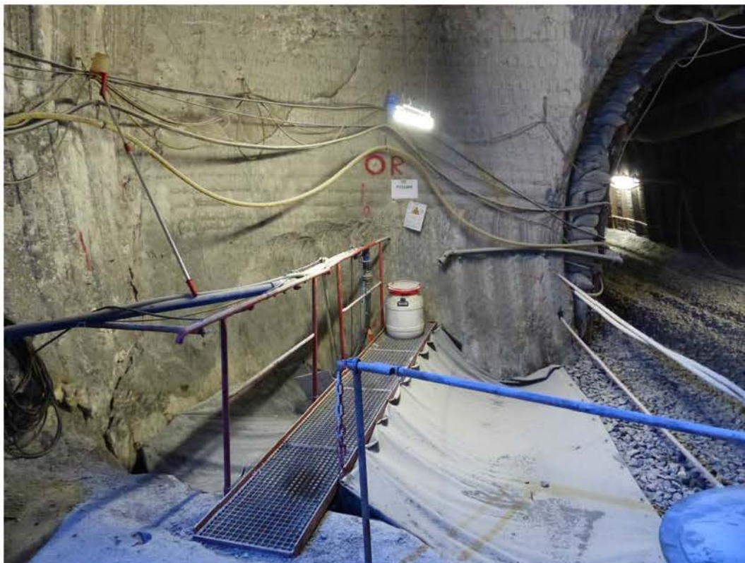
Abbildung 4.49: Katasterstelle P725004 in Pfeiler 2/3 mit Abschaltungen am Nordstoß, Blick nach Osten, 16.02.2018
