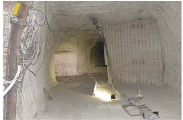
(b) Abgemauerter verfüllter Blindschacht 2 im nach-geschnittenen Pfeiler 4/5 mit nördlich davon abge-hender Nische zur Aufnahme einer Fluchtbohrung, Blick nach Osten, 12.04.2018
