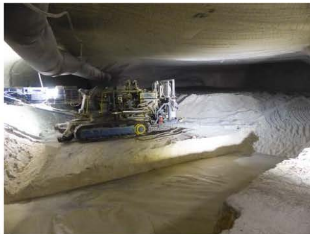
(b) Bereich um den nordwestlichen Eingang des Nebenabbaus 9a/532 mit erstem Betonfundament zur Erstellung der Abdichtbauwerke auf der 532-m-Sohle, Stand: 21.02.2018
