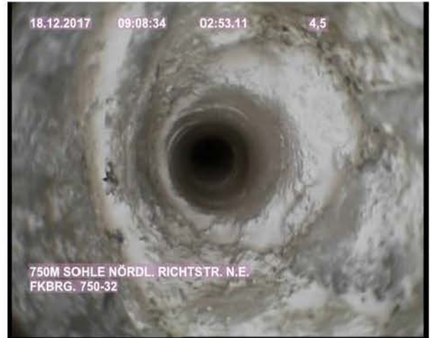
Bild 47: FKBrG. 750-32 – Position bei 4,5 m Übergang Steinsalz–Sorelbeton
