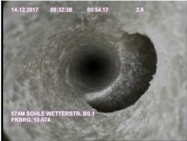
Bild 7: FKBrg. 12/574 – Querung von FKBrg. 13/574 bei 2,6 m
