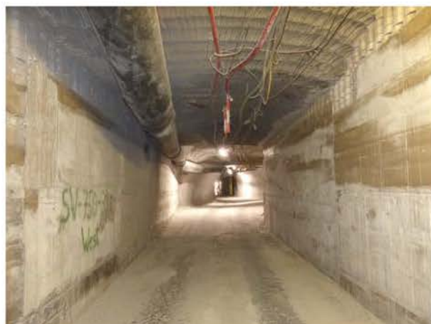
(b) Stützbauwerke im Bereich des entfestigten westlichen Kleinpfeilers (rechts) und vor den Zugängen zu Abbau 4a (Na2) und dem ehem. Holzlager, Blick nach Westen, 22.01.2018
