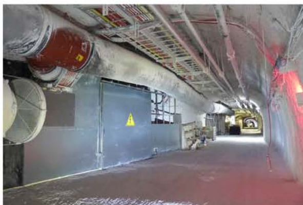
(a) Einrichtung der neuen Trafonischen am Nordstoß im östlichen Abschnitt der Vahlberger Strecke, Blick nach Osten
