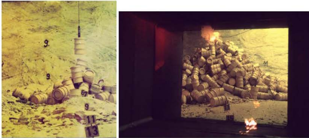
Abbildung 4.21: Fotoaufnahmen der MAW-Kammer auf der 511-m-Sohle. Linkes Bild: 1972, Rechtes Bild: 1984
