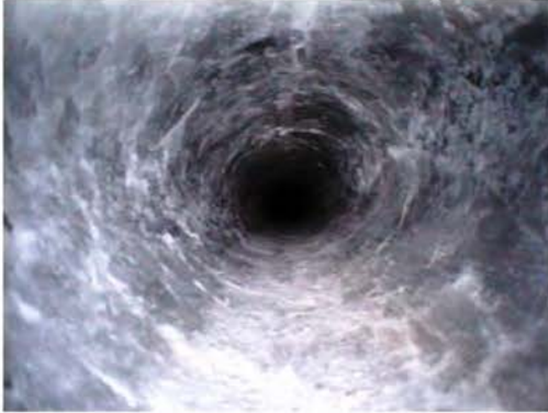
Bild 1: Bohrung 532015; elliptische Bohrlochkontur bei 41 m Bohrlöchentiefe; Aufnahme vom 17.12.2017
