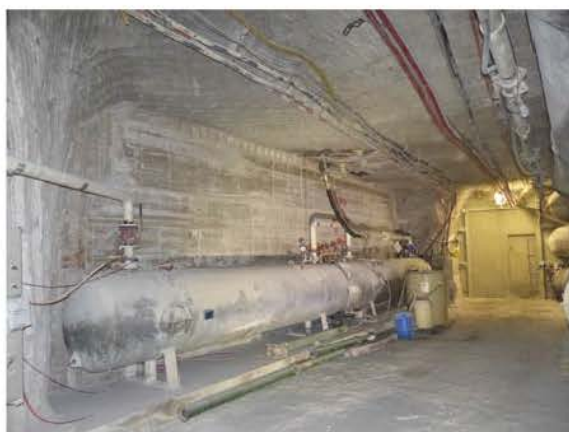
(a) Stützbauwerk in ehem. Kompressorennische am Weststoß des Wetterquerschlags, Blick nach Nordwesten, 19.03.2018
