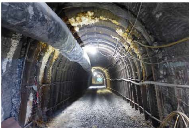
(a) Gleitbogenausbau in Abbau 2 mit korallenförmigen Salzausfällungen, Blick nach Westen, 16.02.2018
